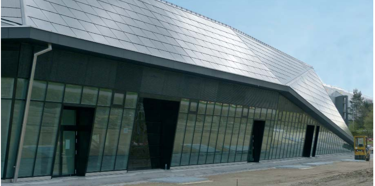
Diese eigenwillige Hallenkonstruktion beinhaltet ein Solardach, das partiell auch die Fassade bildet. Inwieweit auch die geneigten Fensterflächen für Vögel günstig sind, weil sie nur den Boden spiegeln, ist nicht abschliessend geklärt.
