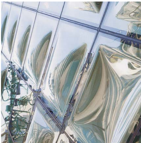
Solche bombierte Glaskacheln wirken zwar auch ziemlich stark spiegelnd,...
