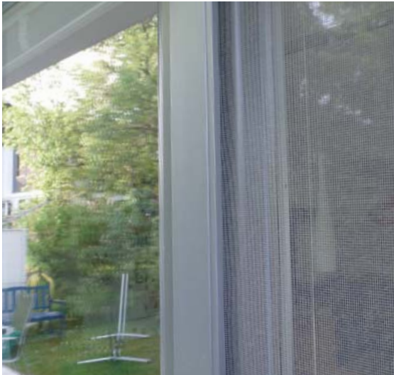
Das aussenseitige Anbringen eines Insektenschutzgitters (rechtes Fenster) reduziert die Spiegelungen stark.
