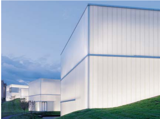
Lichtstreuende Isolierplatten in doppelschaligem U-Profilglas machen Tageslicht nutzbar und reduzieren Wärmeverluste erheblich. Sie sorgen für eine optimale gleichmässige Lichtabgabe in den Raum.
