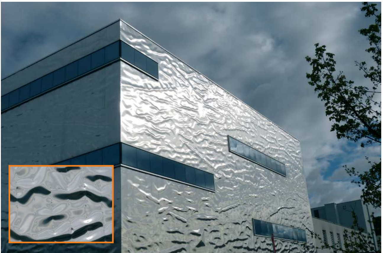
Dieses Lagergebäude ist zwar grossflächig mit einer stark spiegelnden Metallverkleidung ummantelt. Aufgrund der ausgeprägten Wölbungen dürfte es jedoch für Vögel unbedenklich sein.
