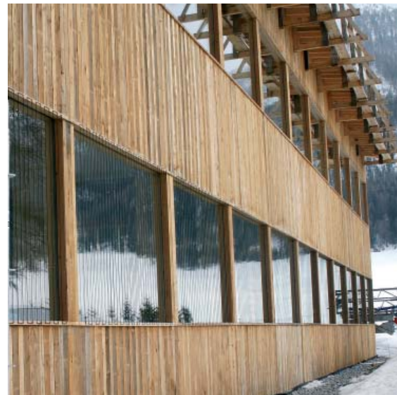
Eine gute und günstige Lösung in diesem Fall: Senkrecht gespannte, schwarze Nygonschnüre.
