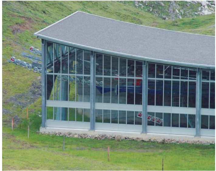
Auf drei Seiten verglaste Talstation einer Bergbahn: Vögel flüchten sich bei spätem Schneefall ins Gebäude und prallen meist von innen an die Scheiben.
