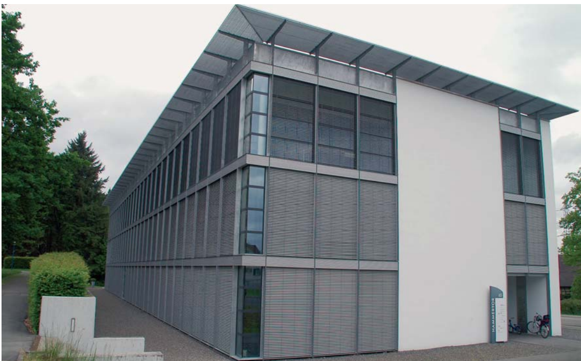
So ist es richtig: Die Jalousien sind an Wochenenden und nach Arbeitsschluss geschlossen.
