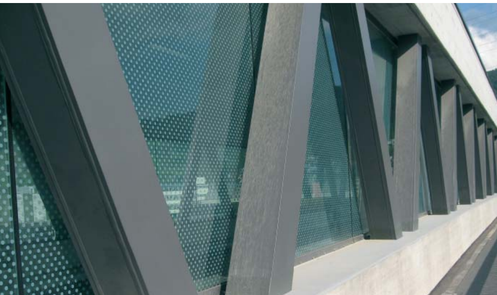
Neue Brücke eines Autobahnzubringers: Die Scheiben wurden durchgehend mit einem relativ grossen, weissen Punktraster versehen.
