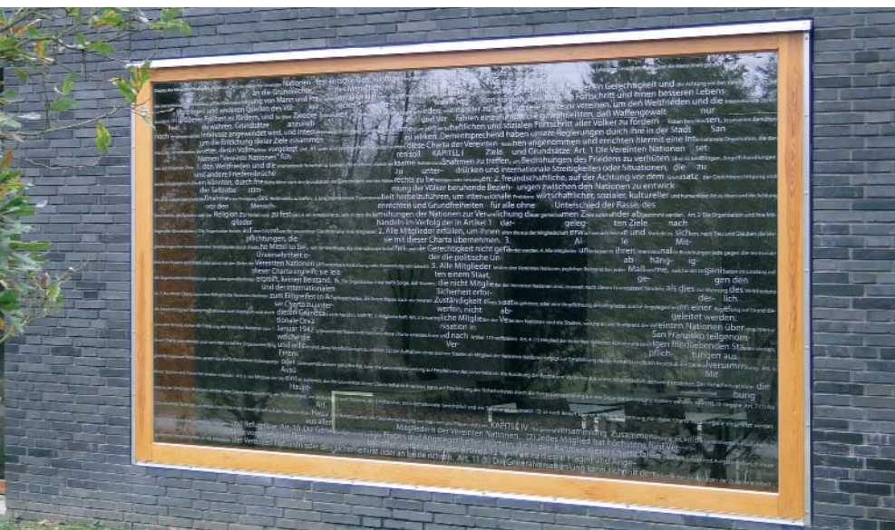
Innovative Sichtbarmachung spiegelnder Scheiben mittels Aufdruck am Auswärtigen Amt, Berlin-Tegel.
