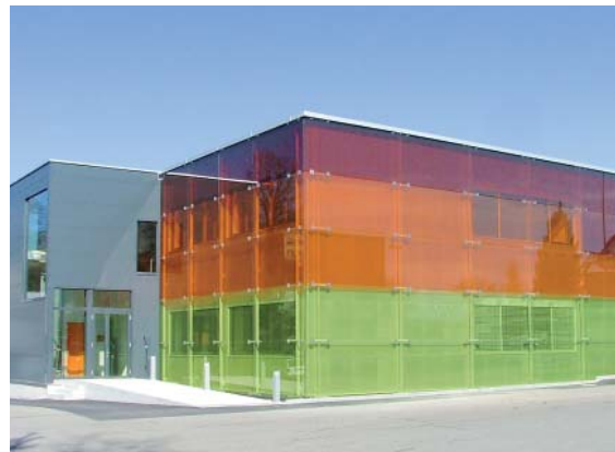
Innovative Polizei-Kommandozentrale: Kaum Problemstellen für die Vögel.
