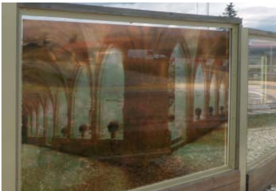
Historisches Motiv, als Film in Lärmschutzwand einlamiert. Leider blieben die benachbarten Elemente transparent.
