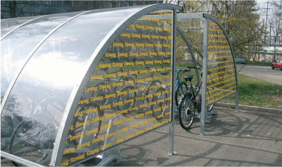
Bei Fahrradunterständen dieser Konstruktionsart sind besonders die Stirnseiten problematisch. Sie wurden hier mit dem Schriftzug des Forschungsinstitutes markiert.
