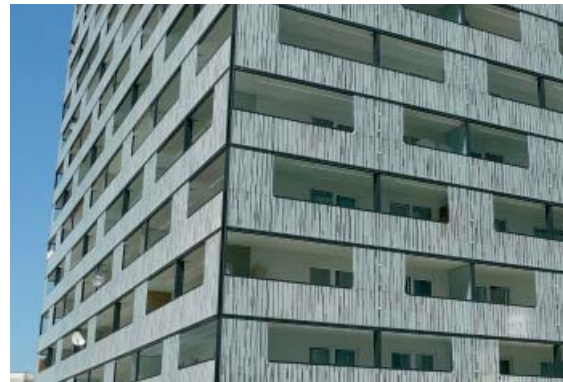
Der Siebdruck gewährt Sichtschutz für die Benutzer der Terrassen und macht die volumenbetonte Gebäudestruktur sichtbar.
