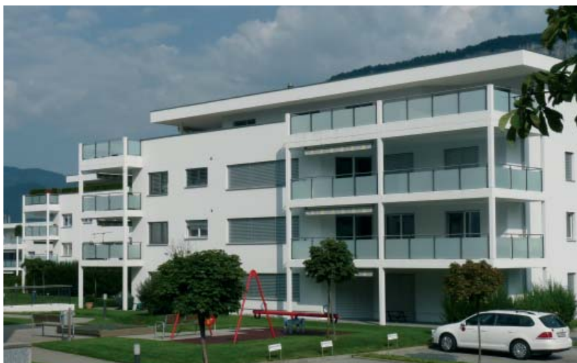
Halbtransparente Balkonverglasungen, hier aus Pressglas, sind keine Gefahr für Vögel.
