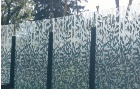
Lärmschutzwand: ist wirksam, trotz pflanzenartigem Design.
